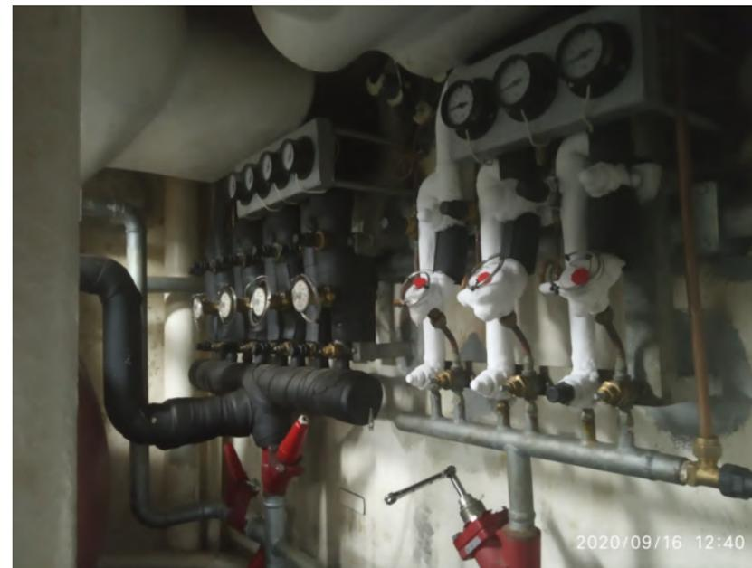
Pianos de válvulas de inyección a túneles (detrás) y bodega (delante), trabajando
