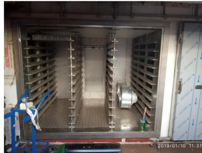
*Túnel ejecutado, con los ventiladores preparados para su instalación*
